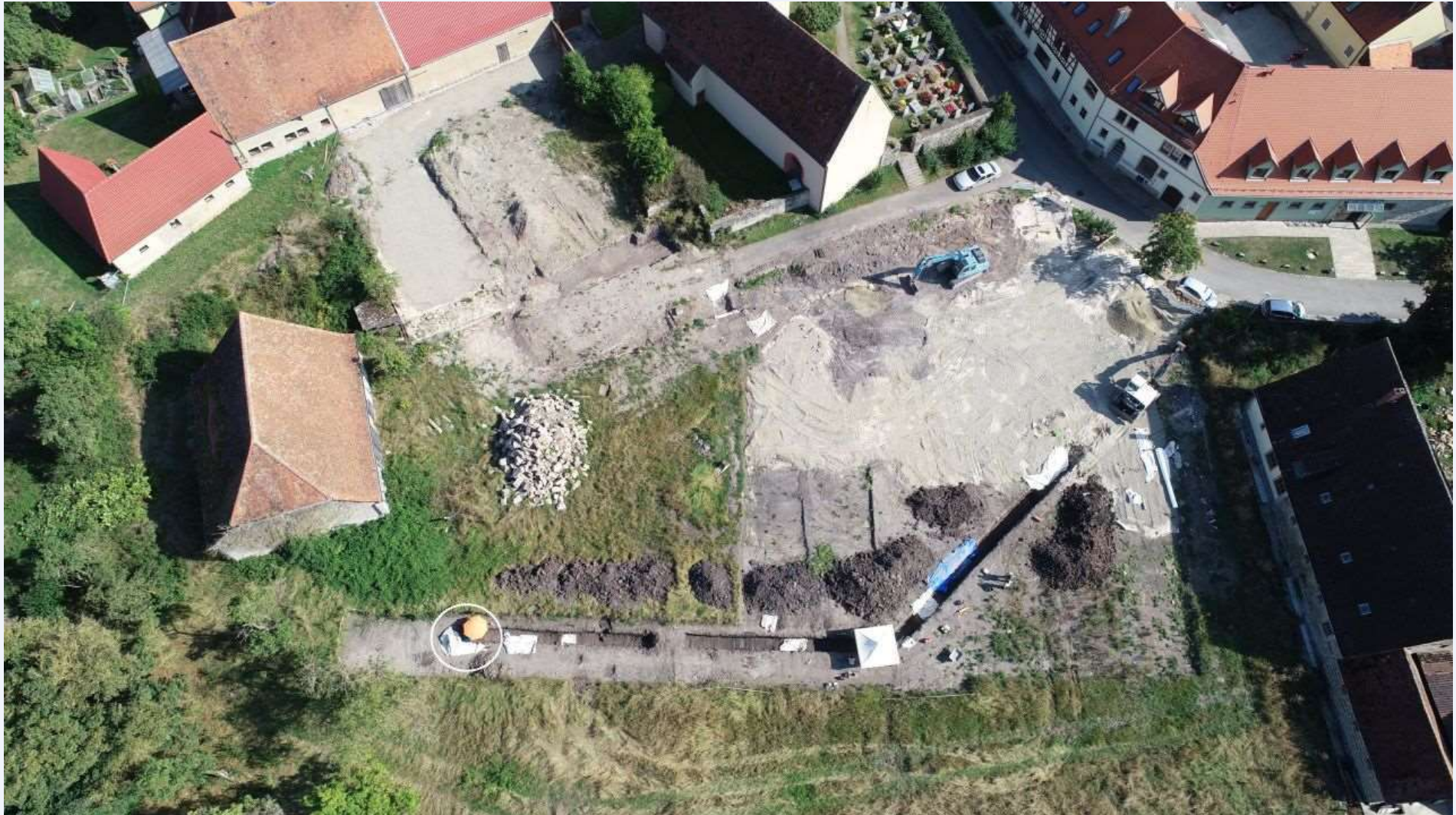
Dorfplatz mit Hauptleitungskanal.
