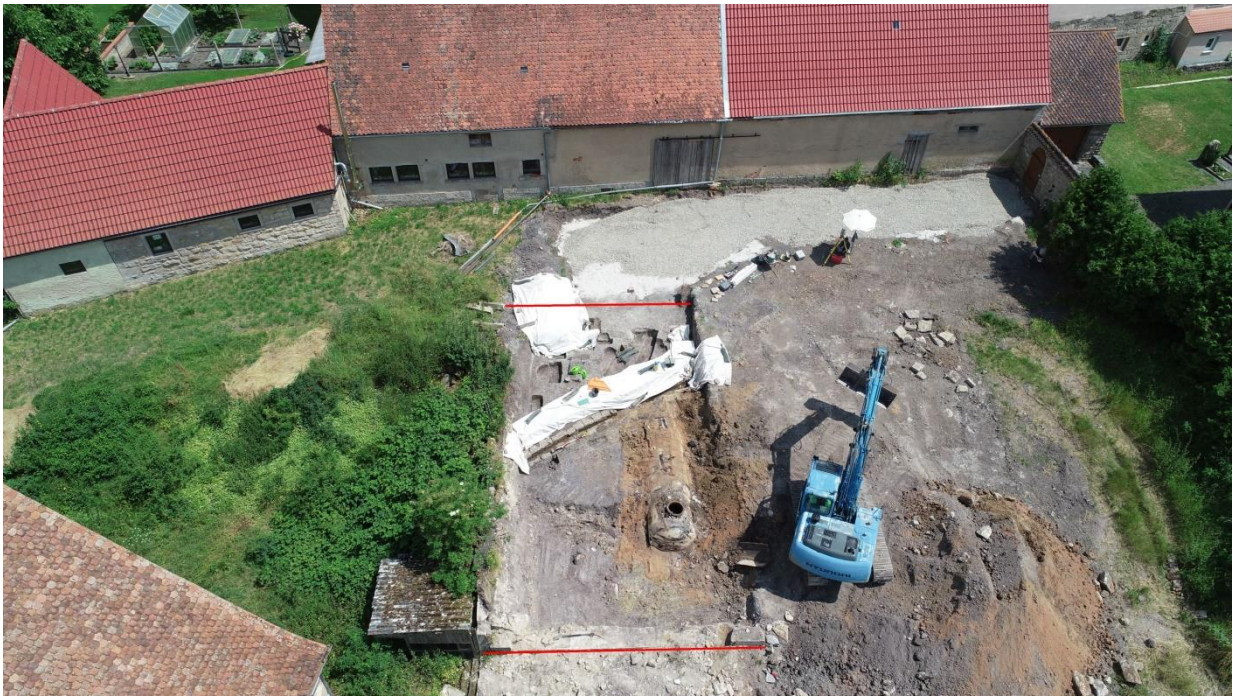
Abb. 40 Friedhofszufahrt Nord (obere Friedhofszufahrt) mit teilweise abgearbeiteten Befunden, Steinkanal und Öltank.
