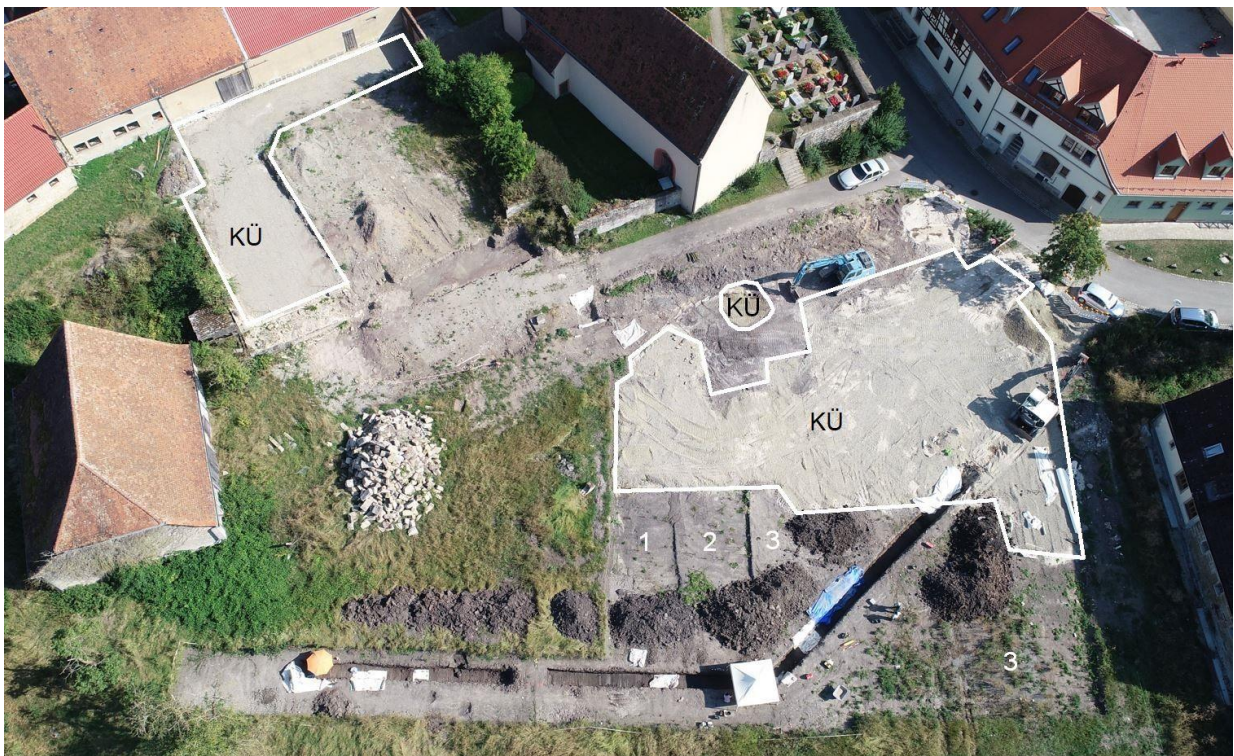
Abb. 15 Die konservatorisch überdeckten Flächen (KÜ) und der teilweise schon offene Leitungskanal am 05.09.2024. Die konservatorische Überdeckung an der oberen Friedhofszufahrt ist verdichtet, die KÜ im Dorfplatzbereich noch unverdichtet. 1 = Bauzieltiefe Parkplatzbereich Befunde auf Planum 1 nur im Osten 2 unter KÜ; 2= Bauzieltiefe Zufahrtsstraße zu den Einfamilienhäusern, 10 cm höher als 1; 3= Bauzieltiefe Dorfplatz, bis 20 cm höher als 1. Unterhalb von 1, 2 und 3 ist definitiv mit Befunden zu rechnen wie die Befunde im Leitungskanal zeigen.
