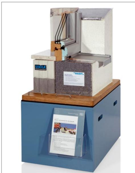
Abb.: Modell Hauswand, Quelle: Ausstellung "Energiewende" des LfU
